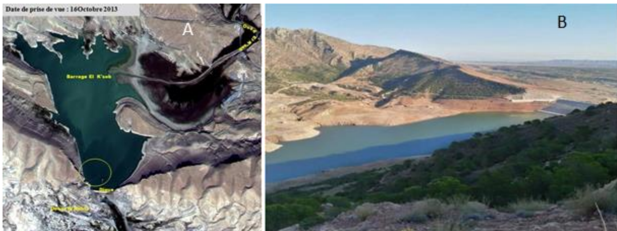
Figure 14 : Barrages de M'sila [81]
