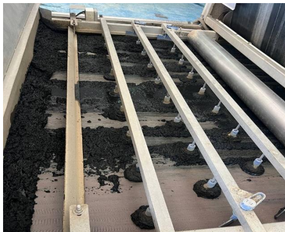
Figure 22 : Filtre à bande lors de la déshydratation de la STEP de Boufarik (Originale, 2025).
