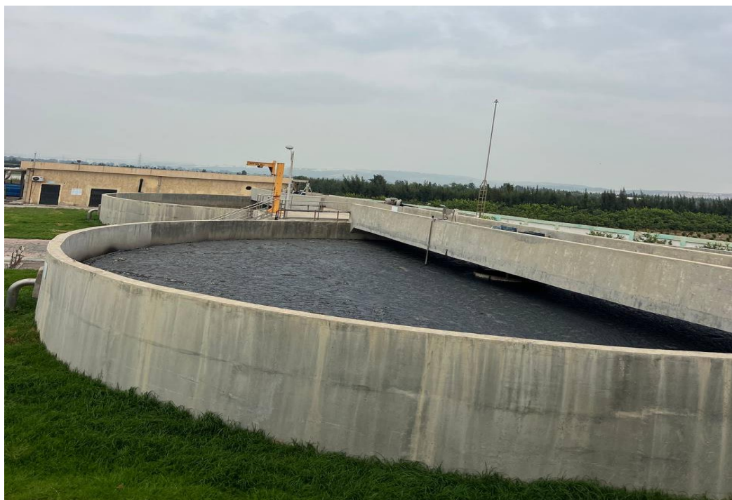
Figure 20 : Les deux épaisseurs de la STEP de Boufarik (Originale, 2025).
