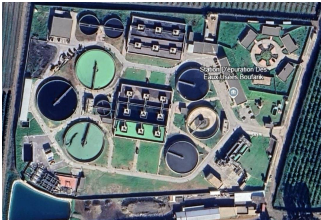
Figure 11: Station d'épuration des eaux usées de boufarik (google earth).
