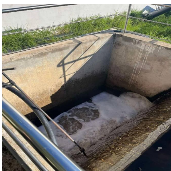
Figure 10: Bassin de désinfection a chicanes (originale, 2025).
