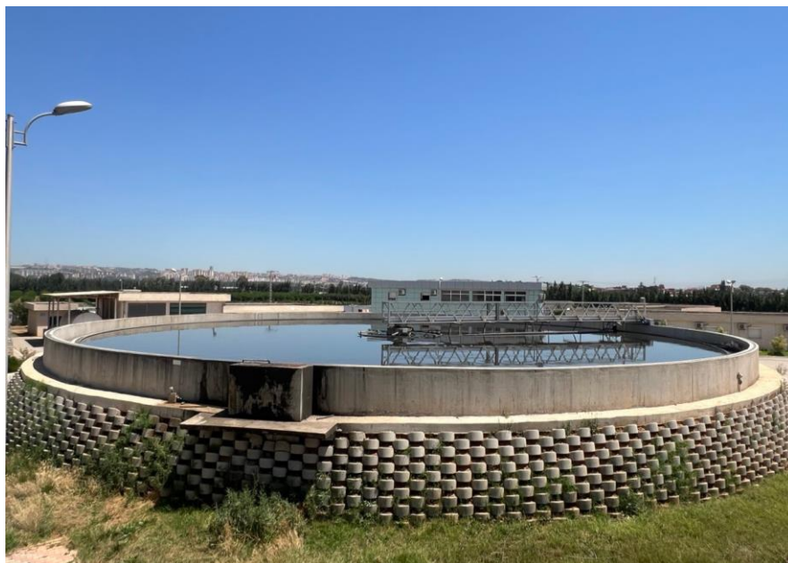
Figure 15: Décanteur primaire de la STEP de Boufarik (Originale, 2025)
