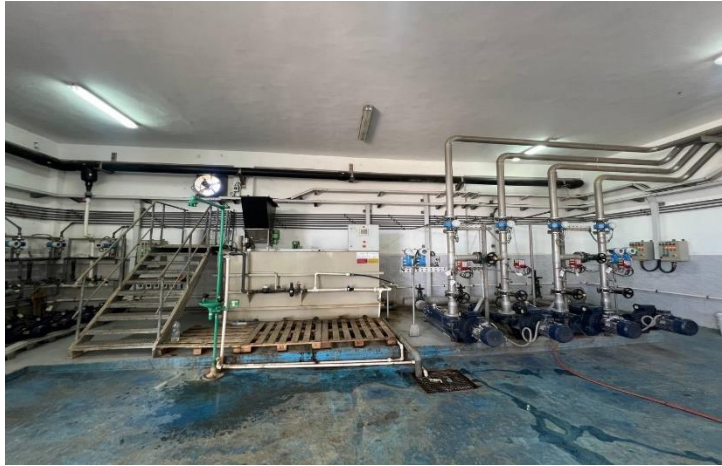
Figure 21 : Atelier de déshydratation de la STEP de Boufarik (Originale, 2025)
