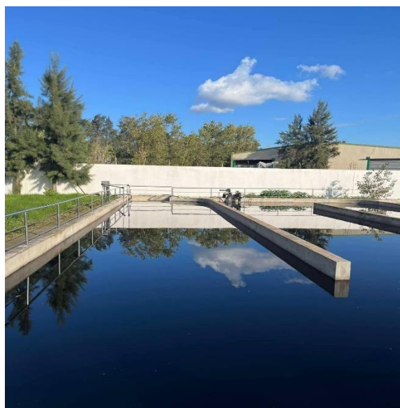
Figure 10: Bassin de désinfection a chicanes (originale, 2025).
