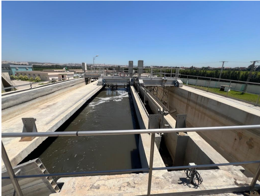
Figure 14 : Dessableur déshuileur de la STEP de Boufarik (originale, 2025).
