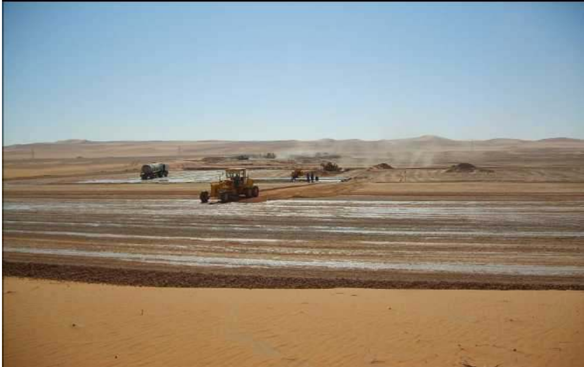
Figure II.4 : Préparation du terrain. [31]
