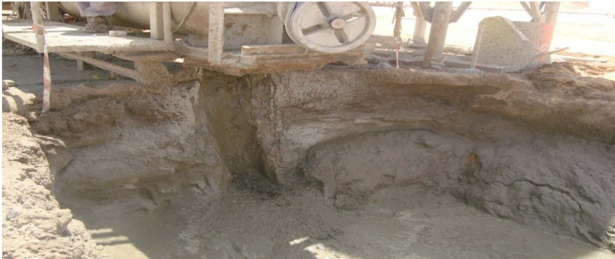
Figure II.7 : Versement du mélange final dans la fosse réceptrice.
