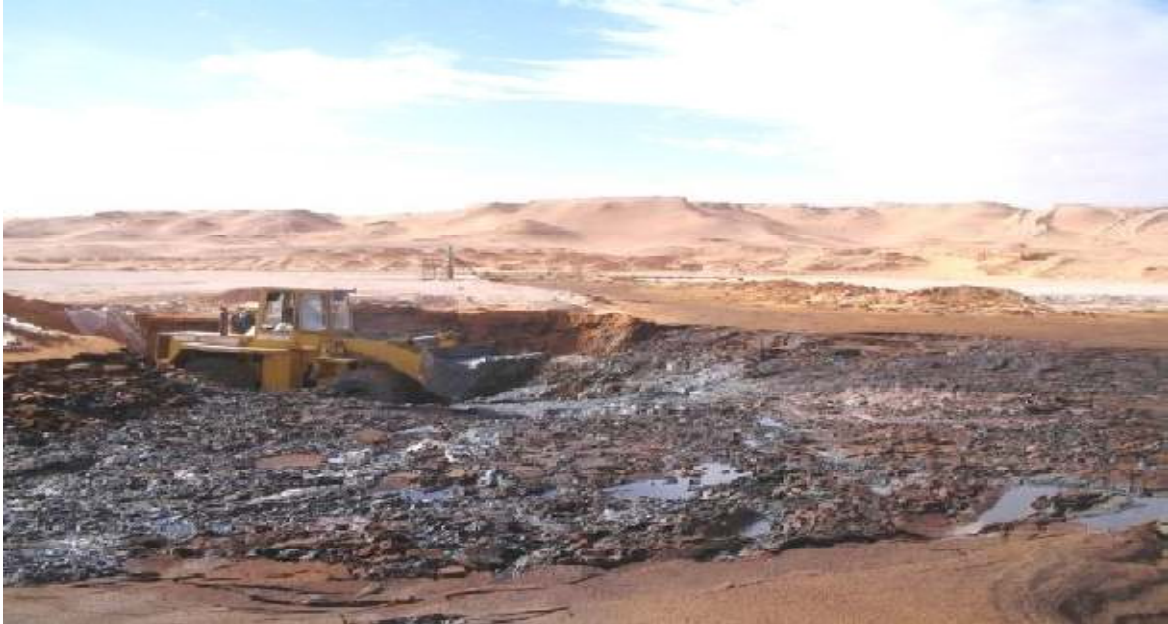
Figure II.5 : Chargement des déblais
