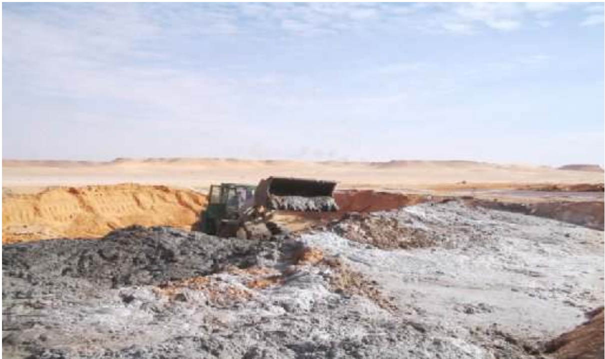
Figure II.8 : Remblayage du cutting traité dans les bourbiers vidés
