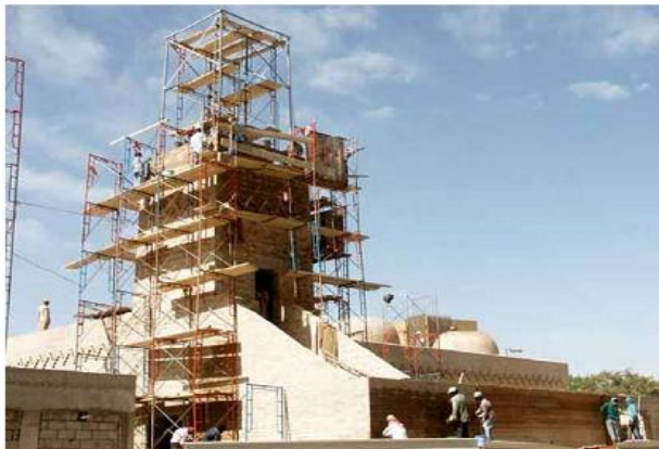
Le cadre en acier a été l'utilisation de contrôler la forme du minaret. Il a été retiré par la suite.
