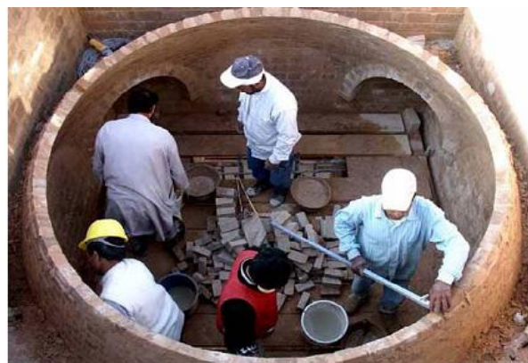
arches de construction sur cintres: Jeu d'équilibre pour décentrer
