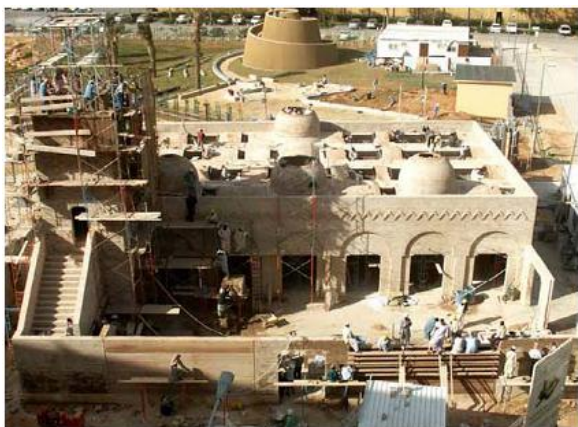
18,05 m de haut minaret avec des murs épaisseurs variant de 59 cm en bas de 24 cm sur le dessus
