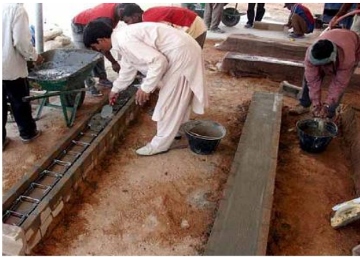
Jetant un linteau composite: barres de renfort sont insérées dans les blocs U et bétonnée
