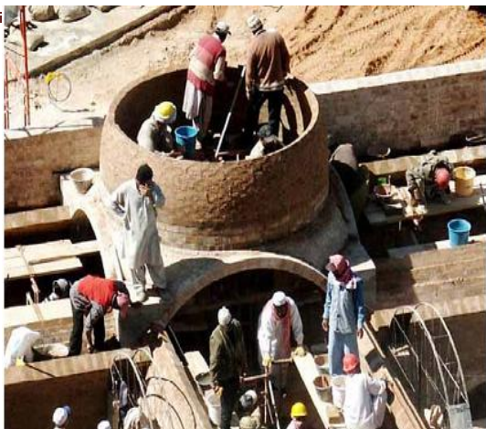
La construction de la coupole hémisphérique 9 m d'épaisseur sur un tambour, à proximité de la Mehrab
