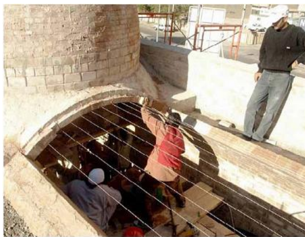
Construire les assises verticales d'une voûte pour la avec la technique de connexion spanning
