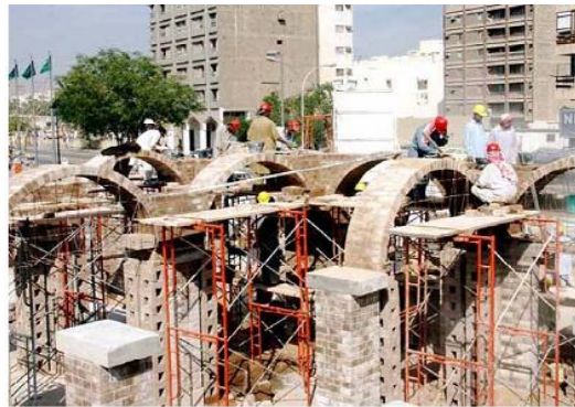
arches de construction sur cintres: Jeu d'équilibre pour décentrer
