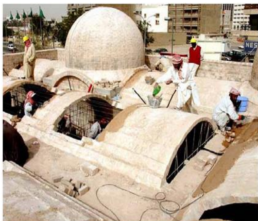
Série de voûtes construites avec des épaisseurs vers le sommet (29 à 7 cm)
