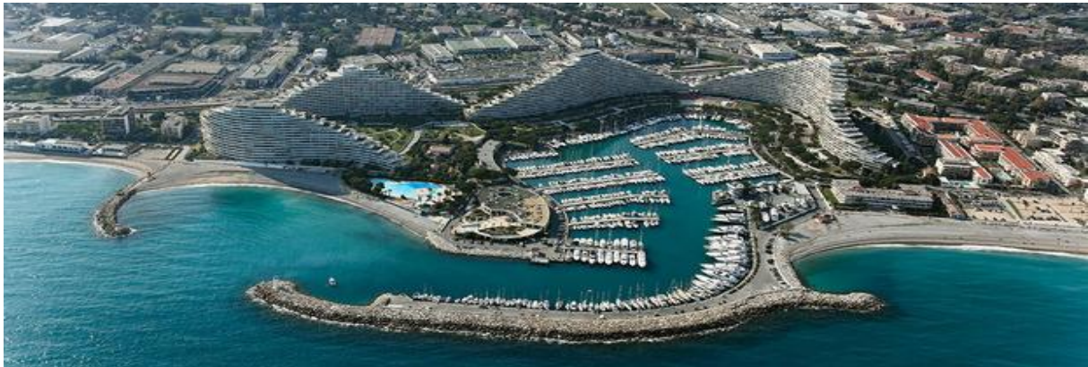
Figure 4 Marina baie des anges
