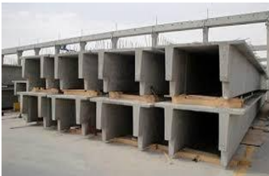
Figure75: Photo d'un plancher nervuré
