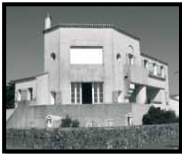
Image 01: Saint-Hilaire-de-Riez. 193 avenue de la Corniche.
