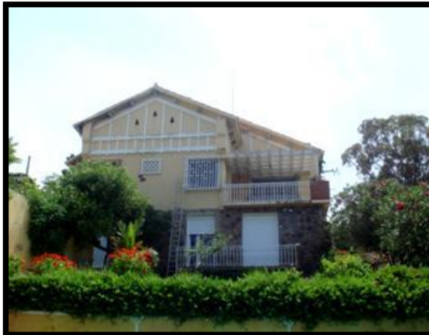
Image 04: Forme de toiture d'une maison de type colonial. la couverture est en charpente en bois couverte en tuile de terre cuite à Ain el Türk Source : mémoire de magister BOUROUMI Mohamed Tewfik.
