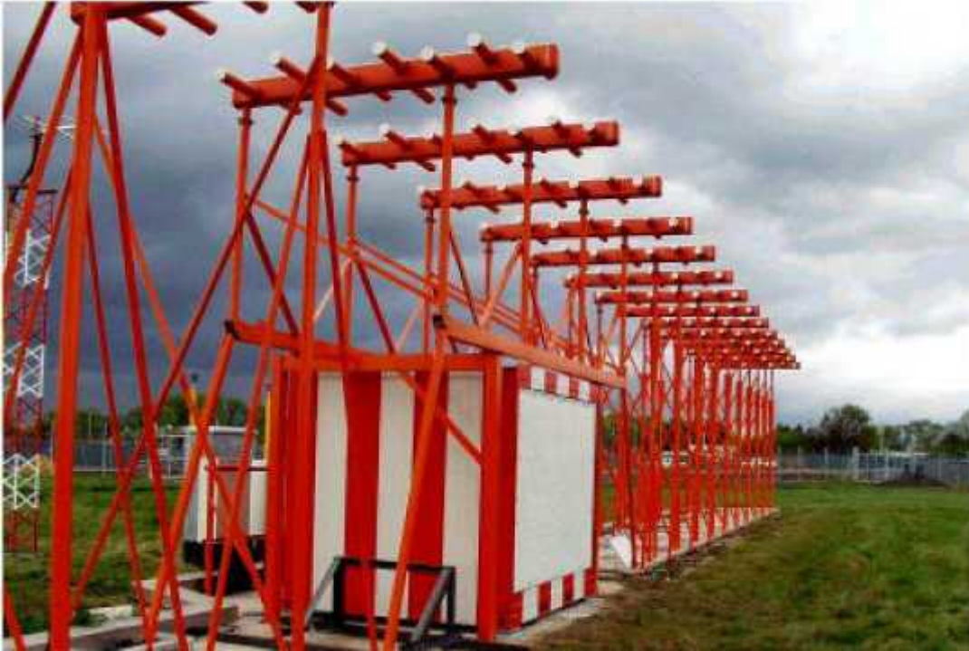
Figure 5.21 : Intégration de Localizer ILS avec élément d'approche azimuthale MLS.
