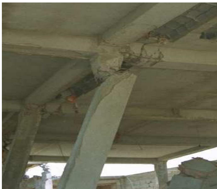
Figure 1.5: éclatement des armatures transversales [47].
