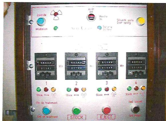
*Figure 4 : Console de programmation de chaque canal de source [16].*
