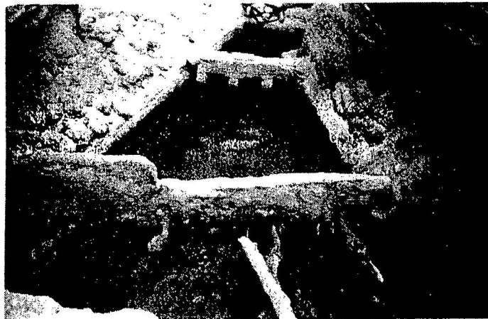
Photo 9 : Kasria principale à la sortie de la foggara d'Amreir
