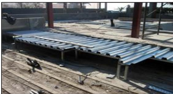
Figure 37 : la composition de plancher collaborant source : <http://www.hiansa.com>)
