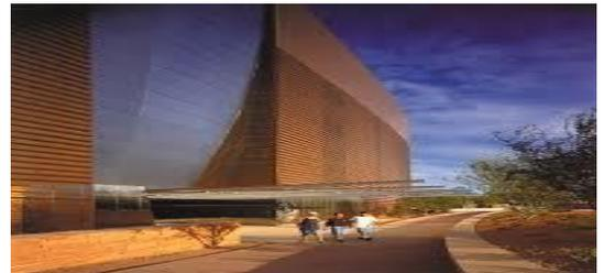
Une protection solaire sur la façade est et ouest par des panneaux en carton ondulé et en cuivre lisse, avec une bande en acier inoxydable vertical couvrant deux fonctions: la protection à l'intérieur de faibles angles solaires et d'éliminer ainsi la concentration brutale de la chaleur solaire
