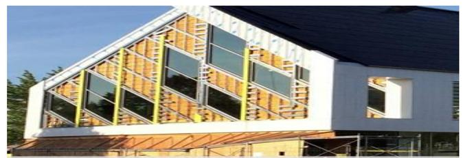
Mur vitré en bois permettant de profiter des gains solaires tout en affichant une performance thermique minimale de R8
