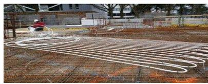
Dalles radiantes comportant un réseau de tuyauterie circulant un mélange d'eau distillée et de propylène glycol [25 %] à 37,2 °C à l'alimentation et à 26,7 °C au retour
