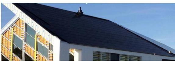
Toiture en pente [inclinaison de 37 degrés] exposée au sud pour optimiser la performance
