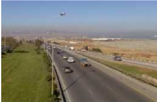
Figure 31 : Rupture entre le nord et le sud (Autoroute) et délaissement du front de mer à El Mohammédia
