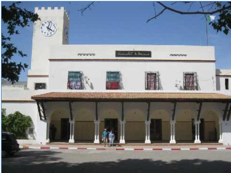
Figure 3 La façade de la gare de Tlemcen
