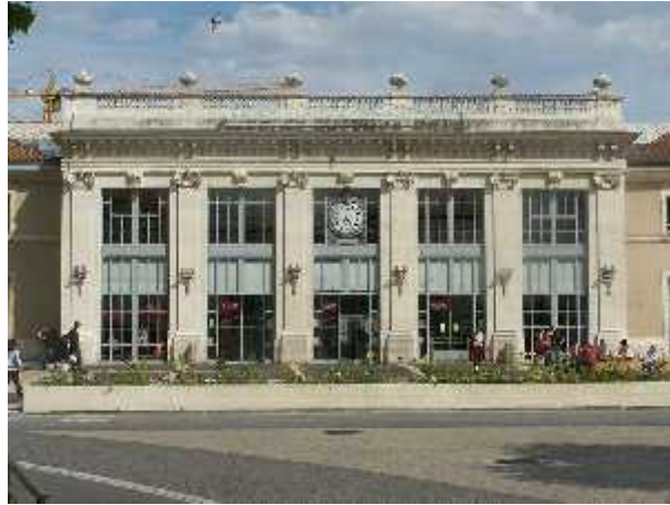
Figure 19 la gare de Valence
