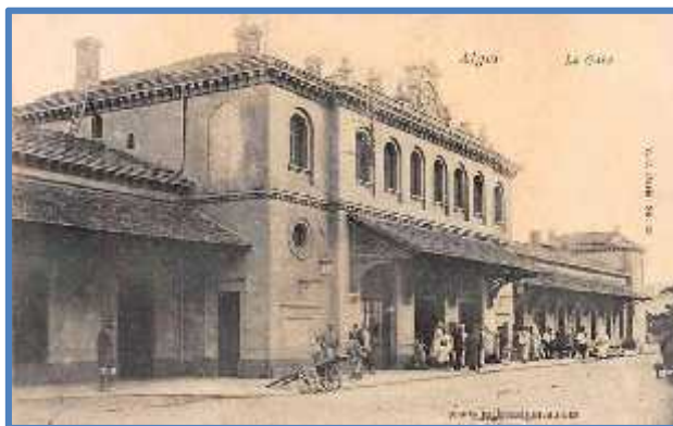
Figure 14 le Bâtiment de voyageurs d'Alger source : les archives de la SNTF
