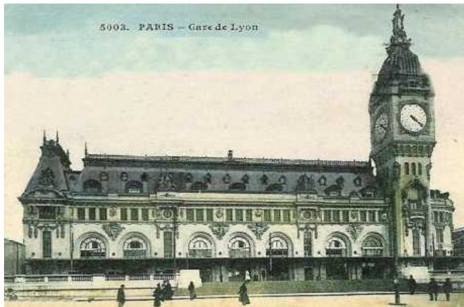
Figure 6 Facade de la Gare de Lyon http://paris1900.lartnouveau.com/paris12/gare_lyon.htm
