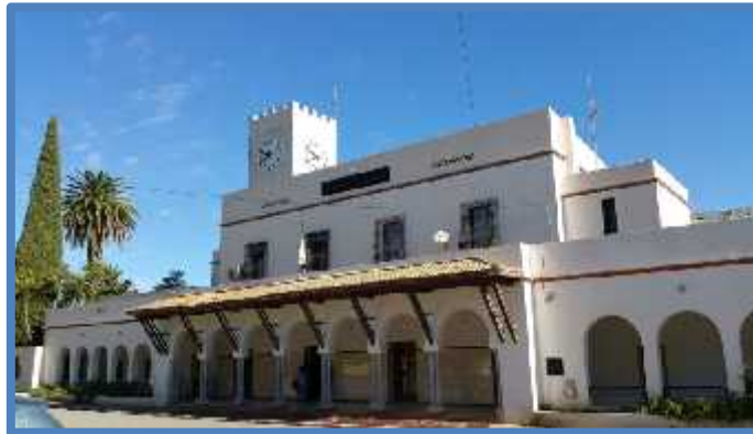
Figure 2 La façade de la gare de Tlemcen source : http://www.vitamedz.org/photo-tlemcen-gare-de-train/Photos_347_187214_13_1.html
