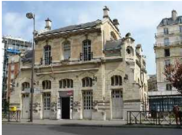
Figure 10 Gare de Boulainvilliers
