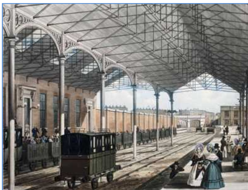
Figure 3 Gravure ancienne de la gare d' Euston montrant le toit de fer forgé de 1837. Noter les voitures ouvertes.
