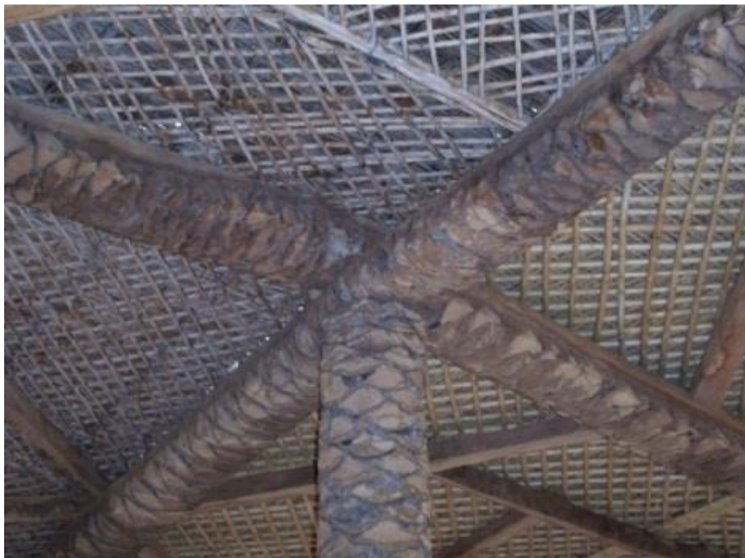
Figure 9 : Piliers et poutres d'une maison traditionnelle
