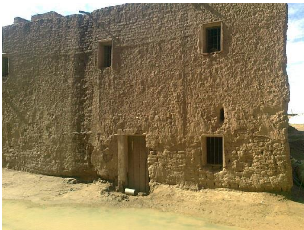
Figure 16 : Présentation la porte et la fenetre d'un habitat traditionnelle
