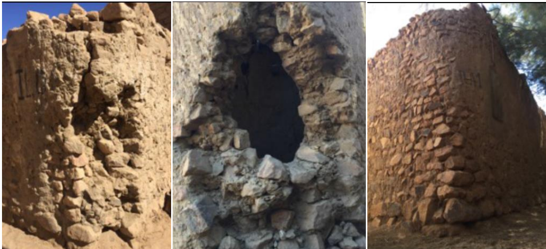
Figure 34 : Les fondations en pierre
