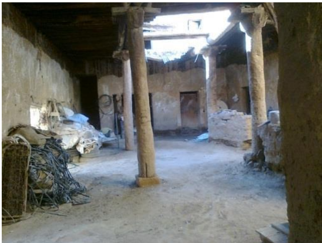
Figure8 Cette grande maison traditionnelle fut soutenue principalement par un grand nombre de tronc de palmiers (poteaux) et par ses larges murs en toubs armés de pailles
