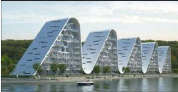
Fig.12 Photo représente la métaphore d'une vague au niveau de la toiture (The Wave in Vejle)
