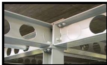
Figure 3.80 : poutre alvéolée
