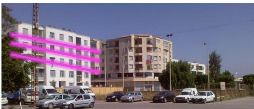
Figure 3.50 : façade de nouvelle extension
