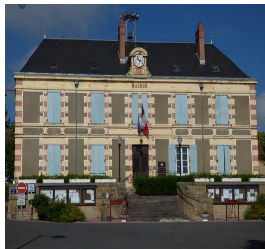
Fig.2.9 :Mairie de Buxières-les-Mines
