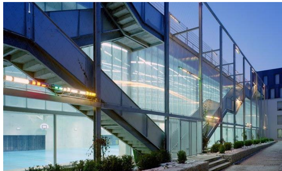
Vue sur la façade postérieure
