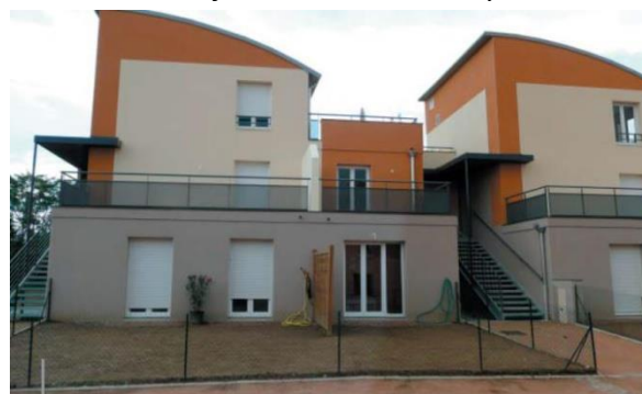
Place Diawara, Longvic (21), 6 logements semi collectif
