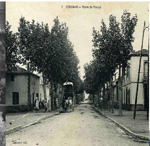
Fig. 13: Centre ville de Bouinan
