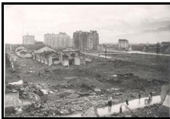
Figure II.6 : la démolition de la caserne
