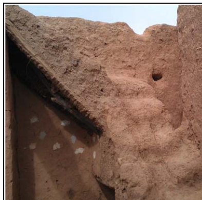
Fig.3.50 escalier sur des troncs de palmier
