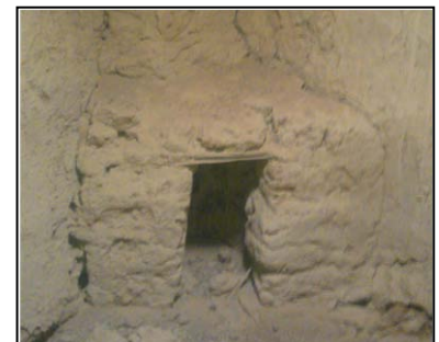
Fig.3.61 Cheminé en terre
