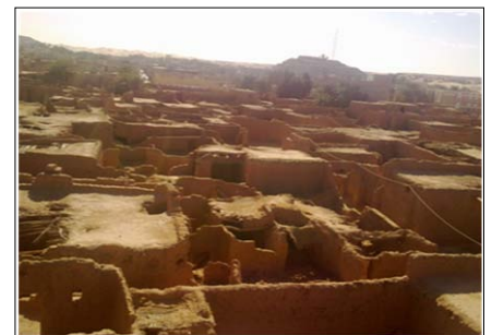
Fig.3.67 vue du ksar
