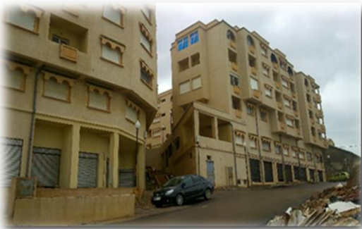
Fig02-34 : façade nord Source:: auteur 2015
