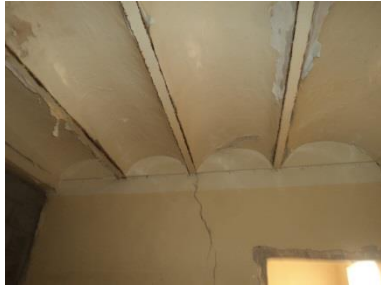
Figure 80: toiture voutain. Source : Prise par l'étudiant.
