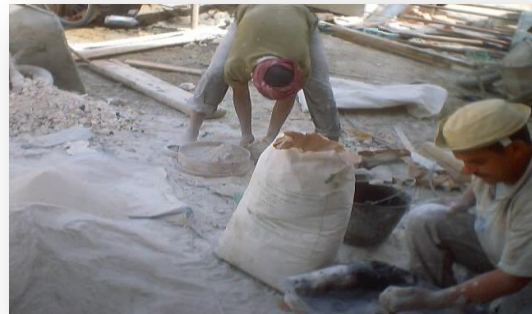
Figure 99: préparation du plâtre. Source : Prise par l'étudiant.
