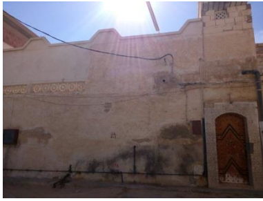
Figure 89: façade des maisons. Source : Prise par l'étudiant.
