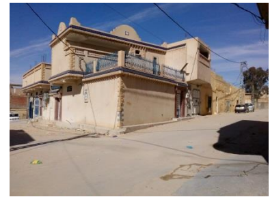
Figure 93: façade des maisons contemporaines. Source : Prise par l'étudiant.
