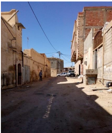
Figure 114: voies non matérialisées. Source : Prise par l'étudiant.
