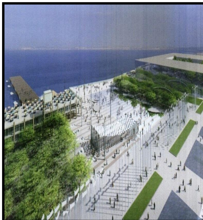
Aménagement placette front de mer
