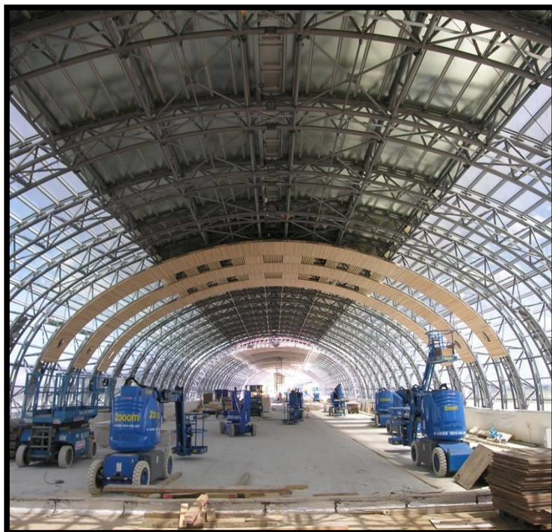
Toiture en structure tridimensionnelle
