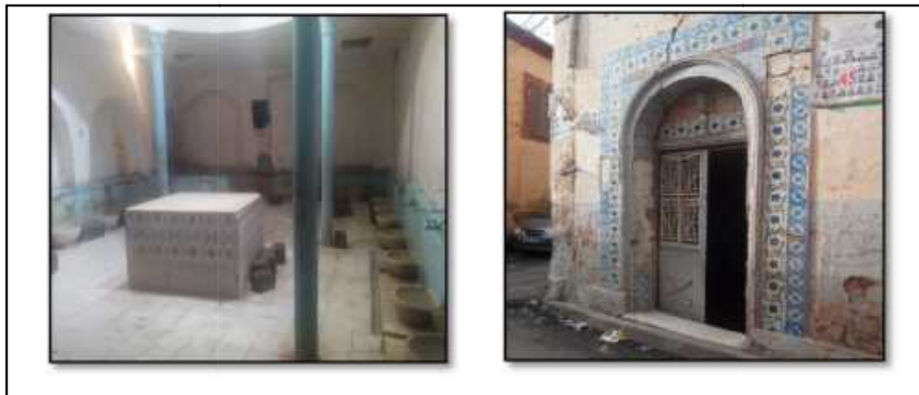
Figure 30 : vue intérieur et extérieur du Hammam Sidi Slimane Source : auteur.
