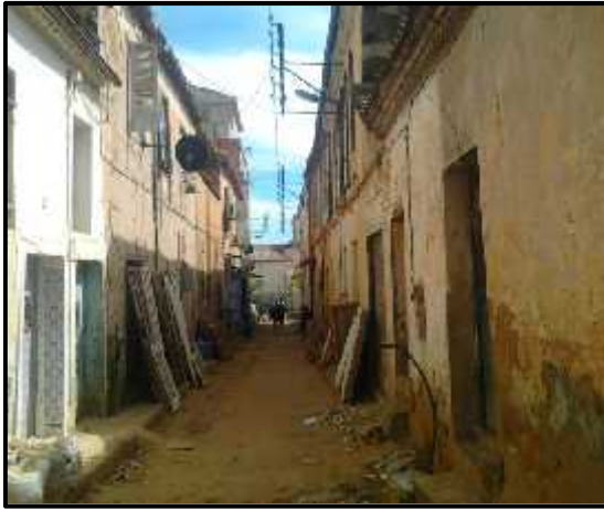
Figure 8 : vue sur une ruelle de la vieille ville Source : auteur
