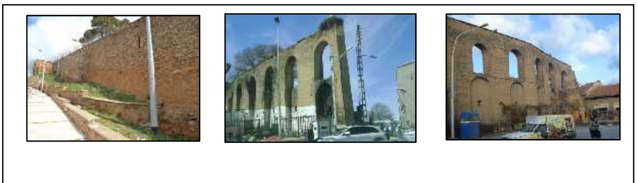
Figure 20 : Différentes vues sur les ponts de murs de l'enceinte préexistante.
