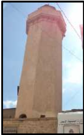
Figure 12: minaret de Djamaa Ahmar après restauration Source : prise par Auteur
