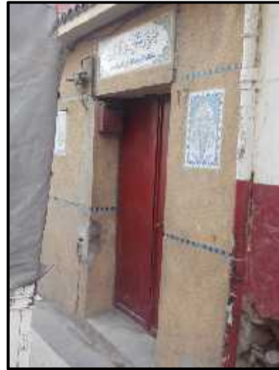
Figure 27 : photo du mausolée Sidi Berkani Source : auteur.
