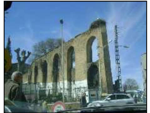
Figure 31 : vue actuelle sur l'aqueduc Source : auteur.
