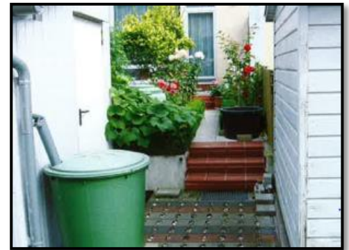
Figure 74: la récupération des eaux pluviales dans le quartier Kronoberg à Hanovre Source : livre urbanisme durable page 261
