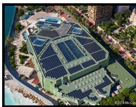
Figure 28 : centrale photovoltaïque Source : https://www.grimaldiforum.com/fr/index/le-grimaldi-forum-devient-la-premiere-centrale-solaire-de-monaco#.XsF7pkQzZdg
