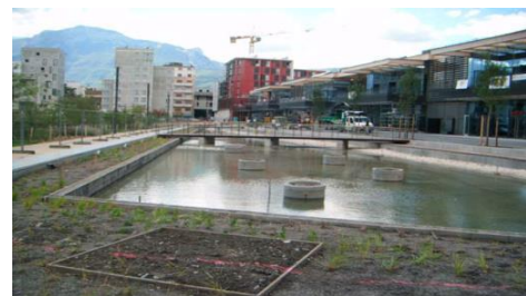
Figure 92.III. Bassin servant de récupération des eaux de pluie, d'agrément paysager, et de stockage d'eau d'arrosage ; ( http://www.eau-poitoucharentes.org/IMG/pdf/rapport_definitif_etude_eau_eq2009-novembre_2011.pdf )
