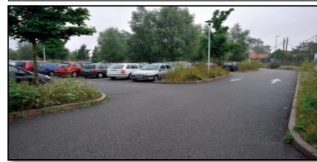
Figure 95.III. Parking avec enrobés poreux a structure réservoir – parking Saint Philibert, Lomme ; ( http://services-urbains.lillemetropole.fr/public/doc/eauxPluviales/08_Fiche_Technique_5.pdf )
