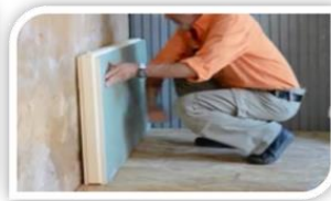
2-fixez le panneaux sur le mur
