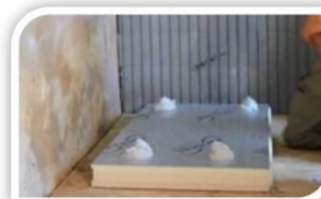
1-mettez la mortier sur le panneaux
