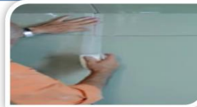
3-utilisez l'adhésif entre les panneaux
