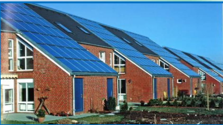
Panneaux photovoltaïque source : web
