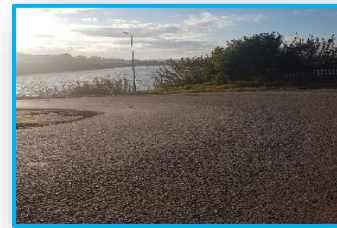
Figure 50 :la route du port Source : auteurs 2019
