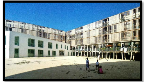
Figure 96 : Sortir chez soi. Source : SilvanaEditoriale, vers de nouveaux logements sociaux 2, cité de l'architecture et
