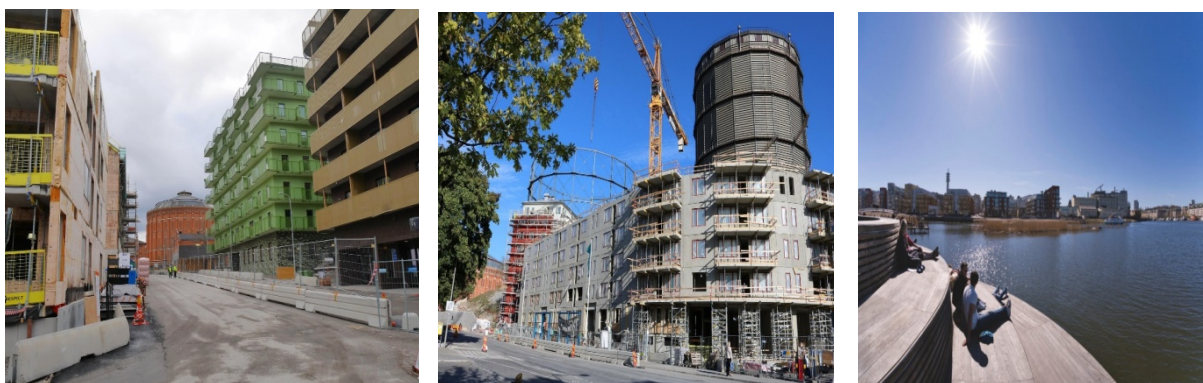
Figure 32: le projet pendant la construction
