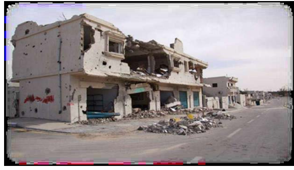
Figure 26: bâtiments risquent de tomber à dakarois source: www. lematinnews.com
