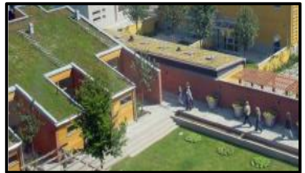
Figure 19 : Une toiture terrasse végétalisée, Source : Quartier Bo01 “cité de demain”, Malmö, Livre L’urbanisme durable, concevoir un éco quartier, en PDF
