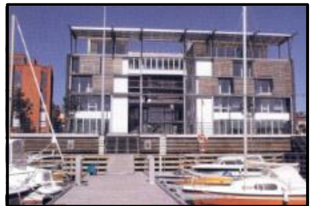
Figure 20 : les panneaux solaires produisent l’électricité, Source : PDF nouveau quartier durable pour Malmö.
