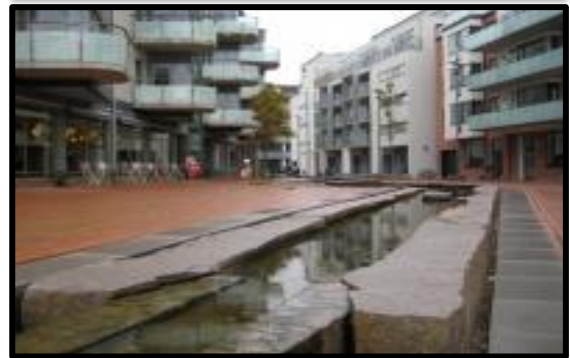
Figure 22: Système d'évacuation des eaux pluviales, Source : PDF nouveau quartier durable pour Malmö.
