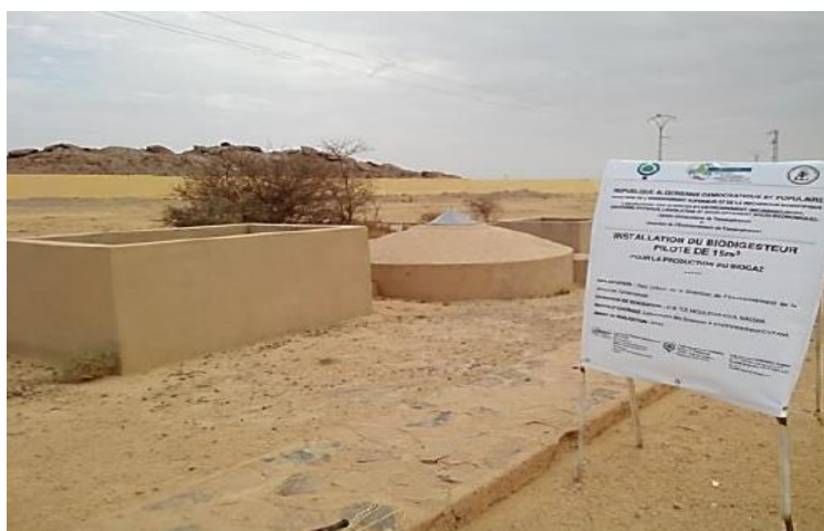
Figure 1 : Le biodigesteur de Tamanrasset de 15 m 3 (Benaïssa, 2019).
