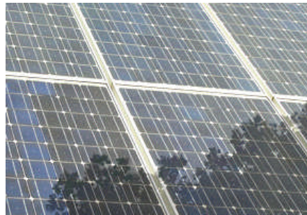
Figure I.5 - Panneau solaire ombragé par un arbre
