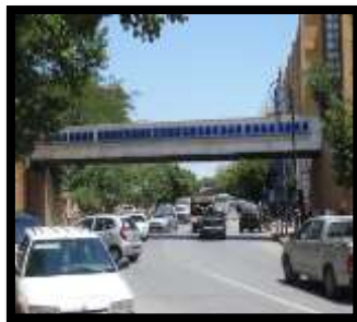
Vue sur le pont
