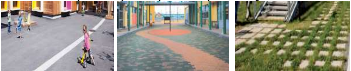
Fig.04.8. un sol enrobé noir - figure 02 : pavés autobloquants - figure03 : pavage mixte (source : Groupe scolaire Paule-et-Joseph-Thiollier Le design pour concevoir une école, France, 2014)
