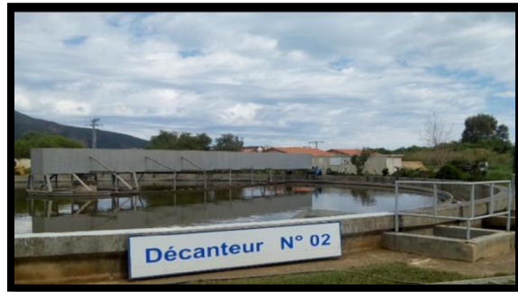
Figure 07 : Décanteur secondaires ((photo originale)
