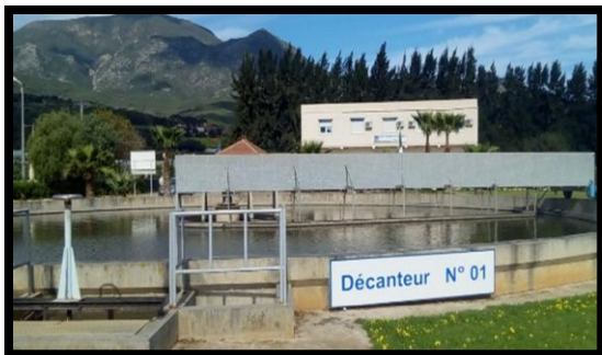
Figure 06 : Décanteur premier (photo originale)
