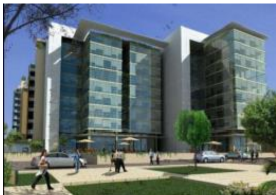
Figure 55 Vue sur l'espace public (le jour)
