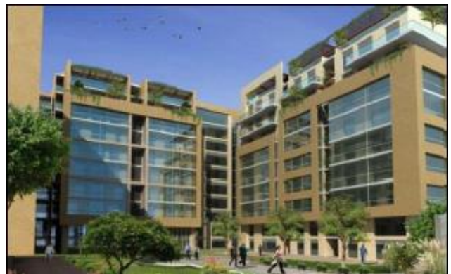
Figure 54 Façade des bâtiments A et C
