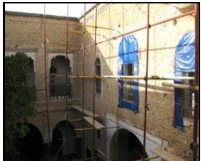
Travaux de décapage des murs.
