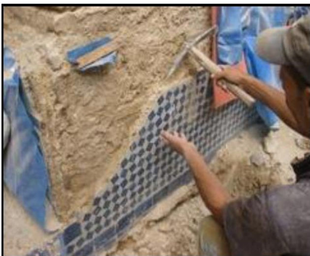
Travaux de dépose des zelliges muraux.
