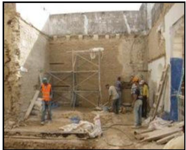
Réfection des murs endommagés.
