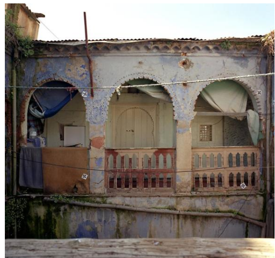
Fig. 16: Façade intérieure de la maison Source: personnelle
