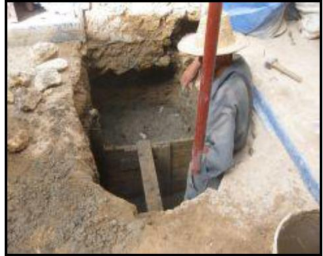
Renforcement d'un pilier.
