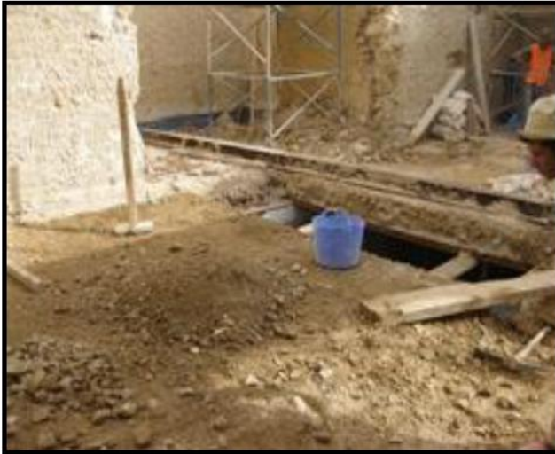
Réfection d'un plancher traditionnel.
