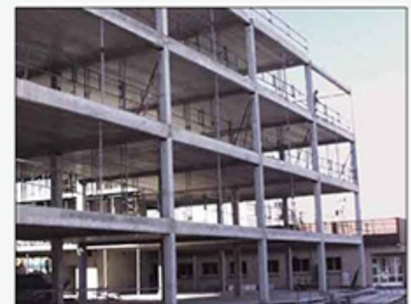
FIGURE: SYSTÈME POTEAU-POUTRE EN BÉTON ARMÉ
