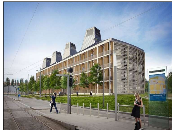
Figure 2.35: l'utilisation de la cheminée solaire dans le siège de Michelin à bordeaux
