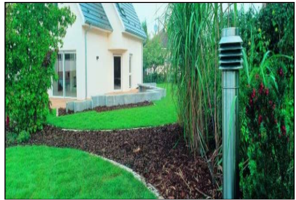
Figure 2.31: maison utilisant le puits canadien Source : bienchezmoi.fr
