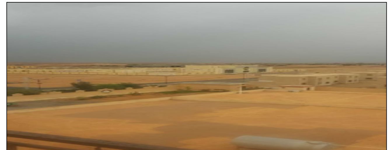
Figure 4.7: groupe scolaire à Béni Abbas Source : Benahmed Djamel
