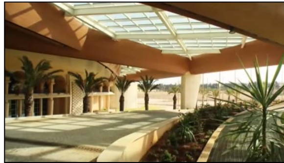
Figure 1.62: la façade d'entrée du CIC Source : Centurion dz
