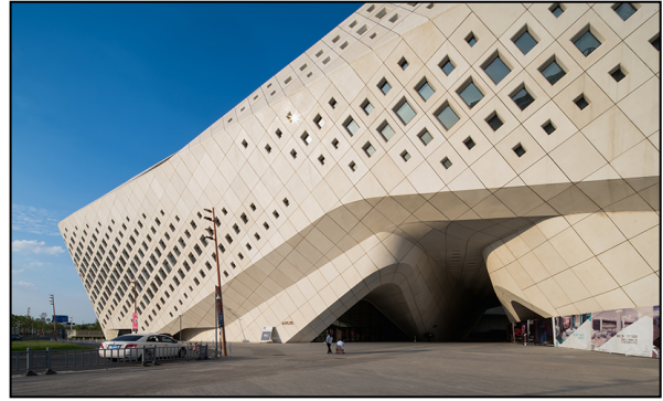
Figure 1.56: la façade du centre de conférence Source : designboom.com
