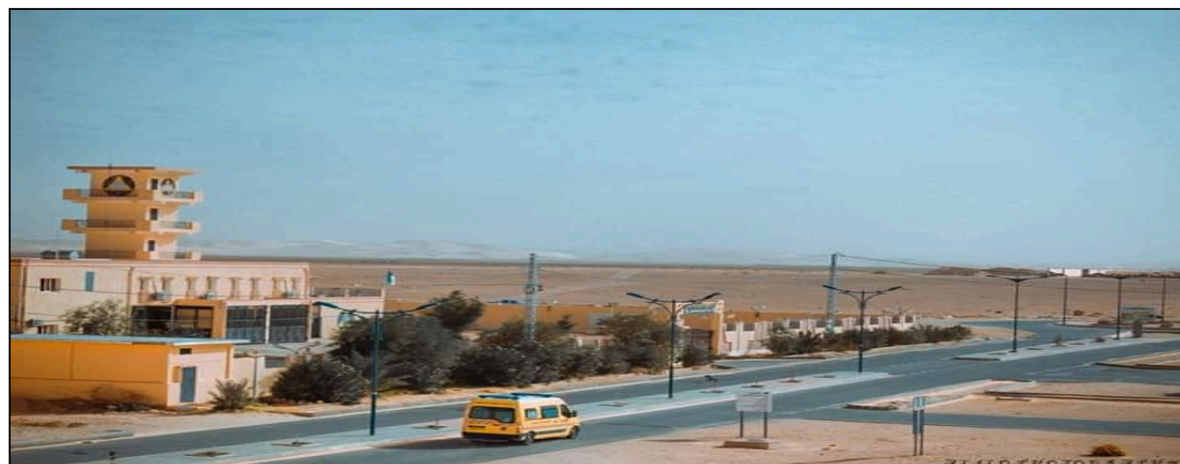
Figure 4.6: vers l'aéroport Source : Benahmed Djamel
