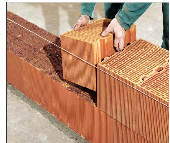
Figure 4.54: mise en œuvre la brique monomur
