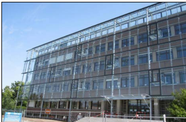
Figure 2.26: façade double peau l'université de boréaux Source : construction21.org
