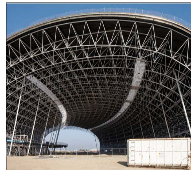
Figure 4.47: poutre triangulée en arc Source : cahiers-techniques-batiment.fr
