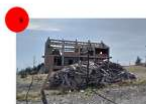
Figure 80. Chantier maison de jaune (Source : auteur)
