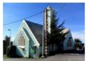
Figure 64. Mosquée. (Source : PDAU 2015)
