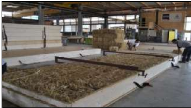
Figure 59: fabrication des mur en enveloppe en bois et isolation en paille / source : (marcom:2007)
