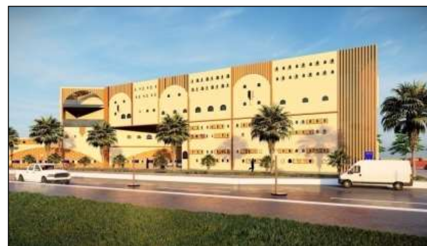
Figure 122: façade sud ouest avec des petite ouverture (se protéger d'effet d'ensablements)
