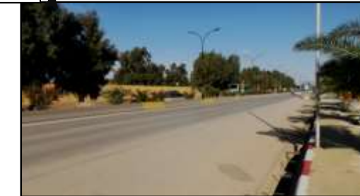
Figure 87: vue sur RN1 / source: auteur
