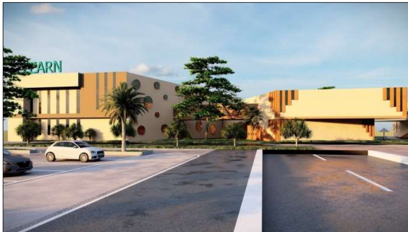
Figure 124: façade principale du bloc d'éducation / source ; auteur
