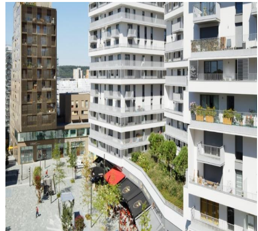
Figure 16 : Vue de haut d'un bâtiment du projet. Source : Auteur.
