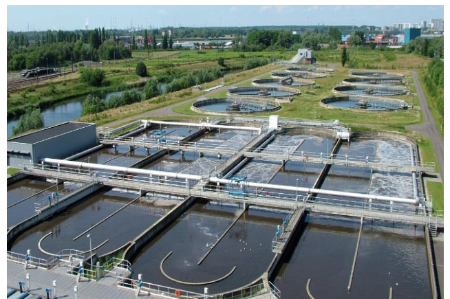
Figure 65 : Station d'épuration des eaux usées. Source : Google image.
