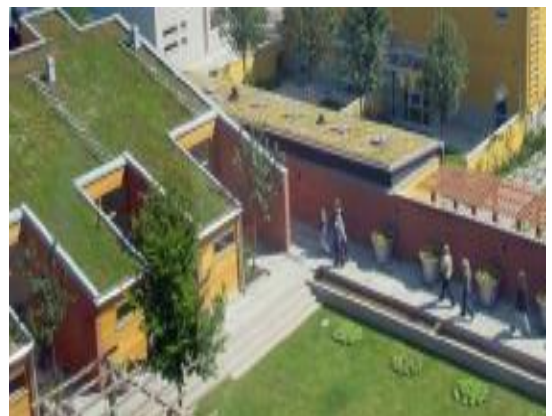
Figure 08 : Une toiture terrasse végétalisée, Source : Quartier Bo01 "cité de demain", Malmö, Livre L'urbanisme durable, concevoir un éco quartier. en PDF.
