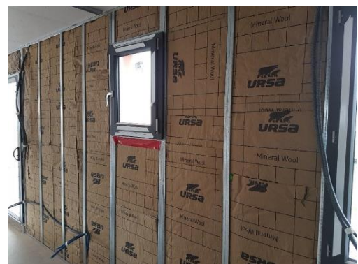
Figure : La pose de l'isolant par l'intérieur
