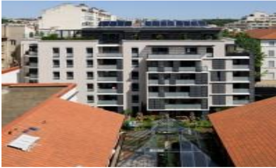
Figure 23 : Un immeuble de logements de standing, Source : https://www.pinterest.fr/pin/681591724824590845/?lp=true .
