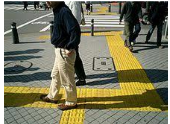
Figure : Chemin extérieur qui permet le guidage des personnes malvoyantes
