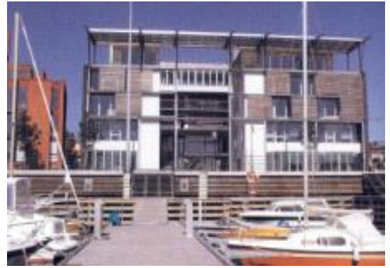
Figure 09 : Façade du projet en cours d'exécution. Source : Livre L'urbanisme durable. concevoir un éco quartier. en PDF.
