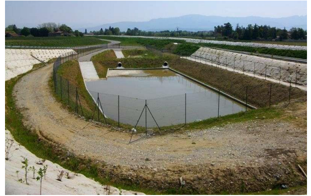
Figure 64 : Bassin de récupération des eaux pluviales. Source : Google image.
