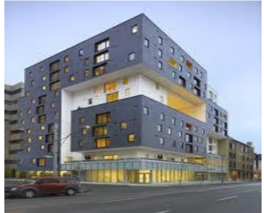
Figure 18 : Vue des bâtiments. Source : Auteur.
