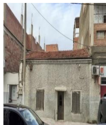
Figure III-29 habitation de l'ilot 1 en rdc en mauvais état
