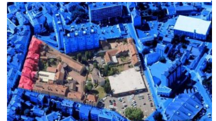
Figure II-12 photo aérienne du projet avant démolition - source un nouvel ecrin pour le centre ville-publier en
