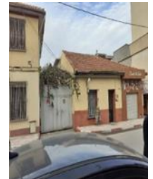
Figure III-34 etat d'une habitation en ilot 2
