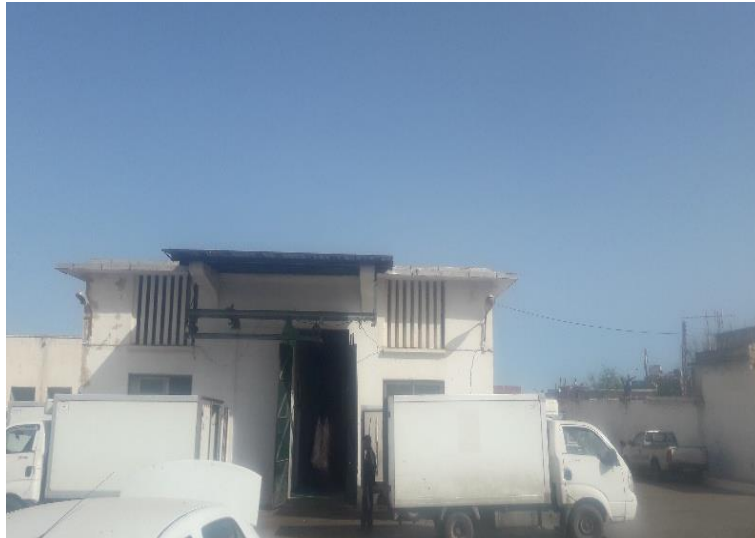
Figure n° 16: Secteur des viandes et abats (photo personnel, abattoir de Mostaganem).
