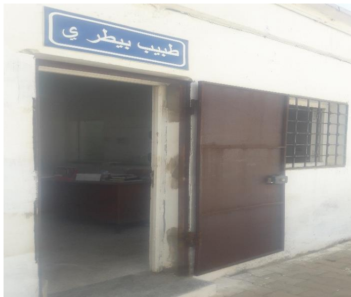
Figure n°15 : Local administratif (photo personnel, abattoir de Mostaganem).
