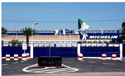
Figure 3 28 usine de Michelin a bachedjerrah Alger source : https://www.algerie360.com/lusine-de-michelin-algerie-ferme-pour-lete-les-employes-attendent-les-offres-de-cevital/
