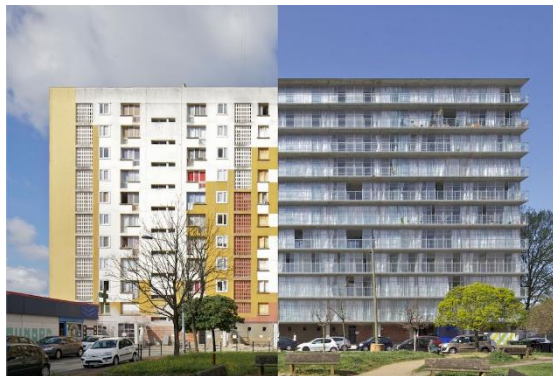
Figure 59: Cité de Grand-Parc a bordeaux avant et apres exterior batiment G,Source :Philippe ruault.
