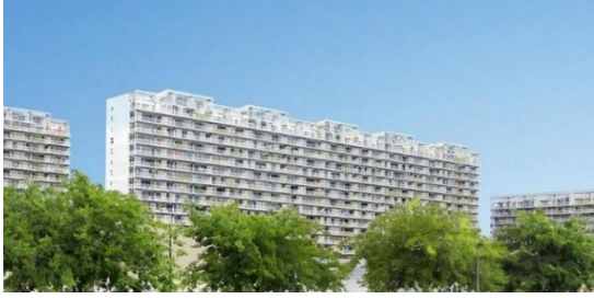
Figure 58 : Vue sur la façade Sud après réhabilitation, Source : Aquitanis.
