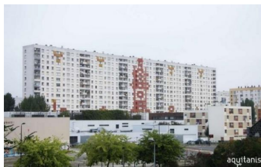
Figure 57 : Vue sur la façade Sud avant réhabilitation, Source : Aquitains.
