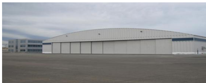
Figure I.5: Centres d'exploitation et de maintenance de Tassili Airlines.
