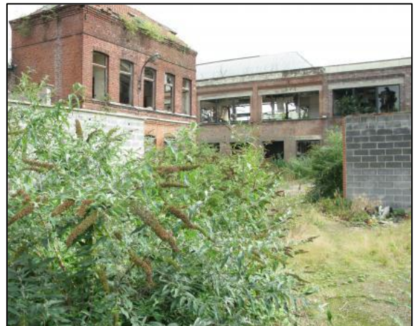
Figure 2.8 : photo l'état dégradé du centre-ville de Roubaix (source Google Earth)
