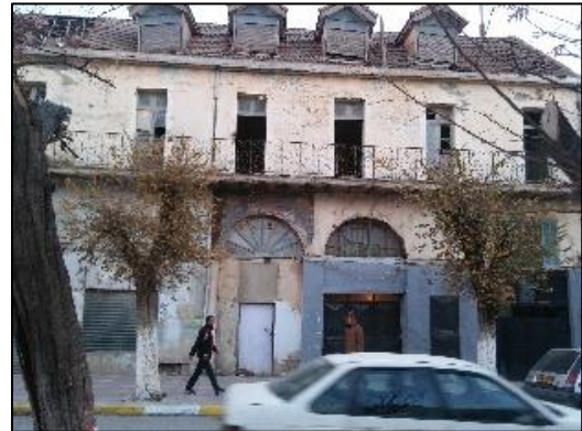
Figure 3.35 : Façade d'équipement abandonné
