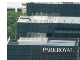
Figure 80: Panneaux solaires sur le toit
