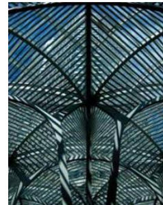
Figure 30: La structure de plafond de la galerie et de l'atrium Allen Lambert à Brookfield. Source : Image © Reto
