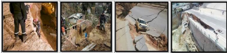
Figure 102: Des photos d'un glissement de terrain sur la route nationale N 11. Source : www.algeriepatriotique.com
