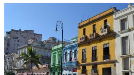
Figure II-21: Immeuble rénové à Saint Domingue Source : Google Image
