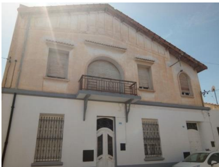
Figure III-74: Bâti en bon état Source : Auteur, prise-le 22/06/2019
