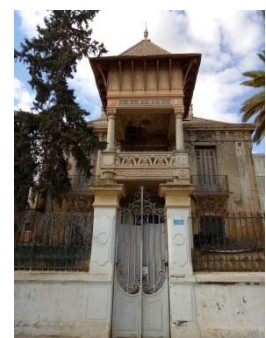
Figure III-73: Bâti en état dégradé Source : Auteur, prise-le 22/06/2019
