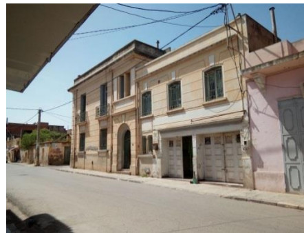
Figure III-71: Bâti en moyen état Source : Auteur, prise-le 22/06/2019
