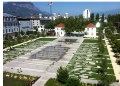
Figure III-91: Vue sur les tranchées drainantes dans le quartier de Bonne à Grenoble Source : http://transitionpositive.org/2018/02/e_coquartier-de-bonne-grenoble/
