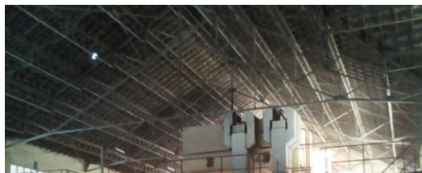
Figure III-47: Vue intérieure de la toiture de la coopérative Source : Mémoire
