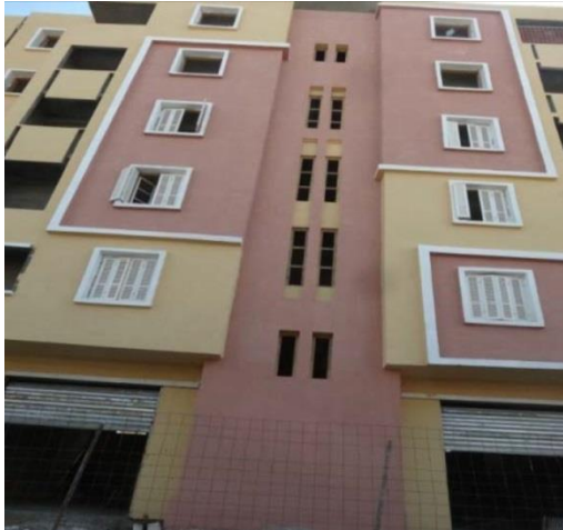
Figure III-66: Modèle de façade des constructions récentes Source : Mémoire
